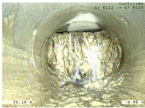
En effet, sans l'intervention prévue, visant l'élimination totale ou partielle du calcaire présent dans ces différentes canalisations, le risque d'inondations sur les chemins est grand, car l'évacuation des eaux ne peut plus se faire correctement en cas de fortes pluies.
