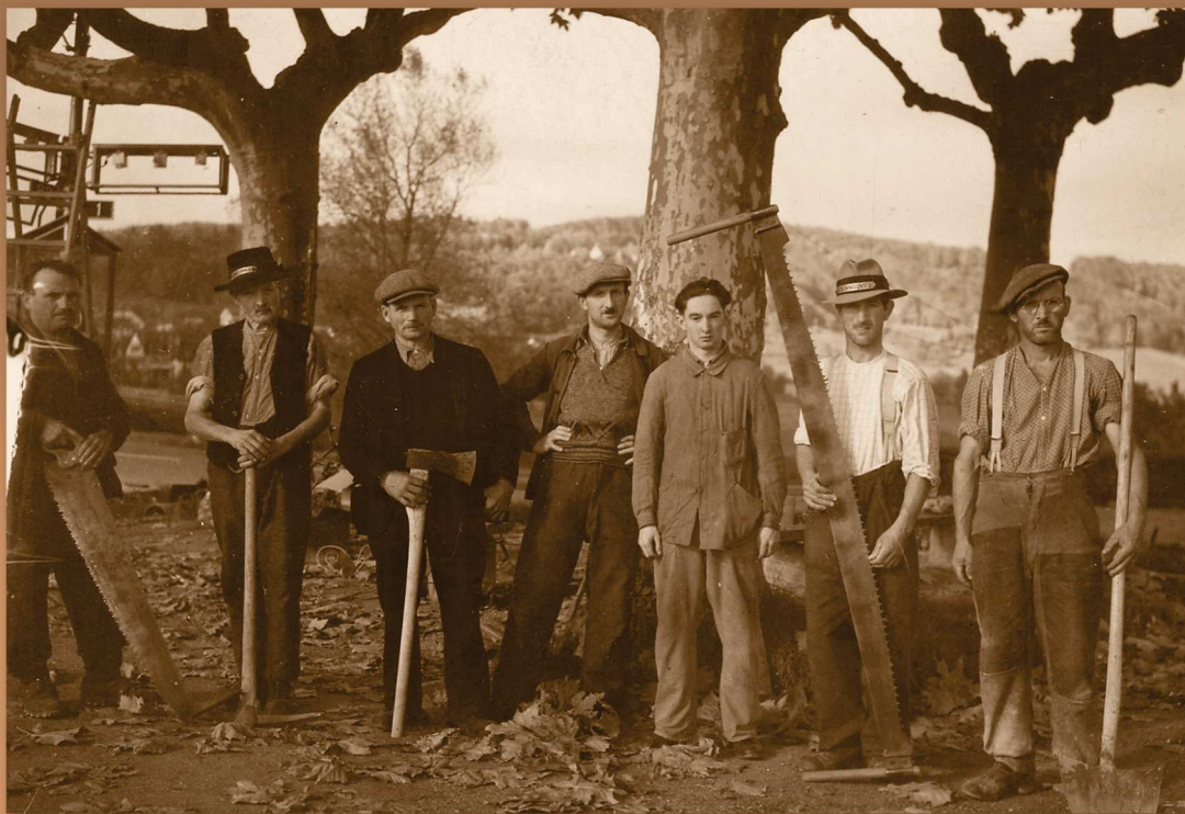
Ouvriers engagés vers le pont de la Broye à la sortie de Lucens. (collection privée M.H. Sonnard).
